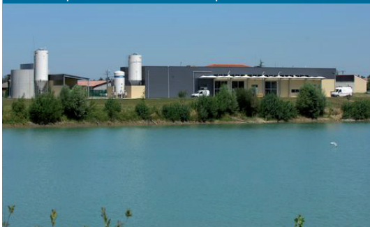
Usine de production d'eau de Roques
